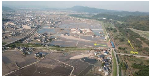
岡山県倉敷市真備町における小田川の破堤氾濫による被災概況
